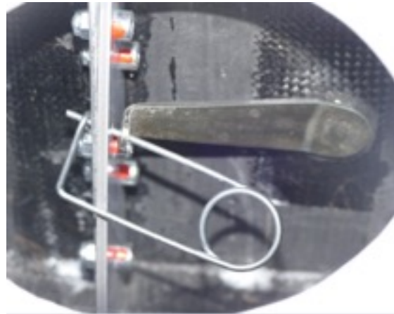
Fokker-Nadel sichert Flügelbolzen am äußeren Flügelstummel; Zugang über Handloch
