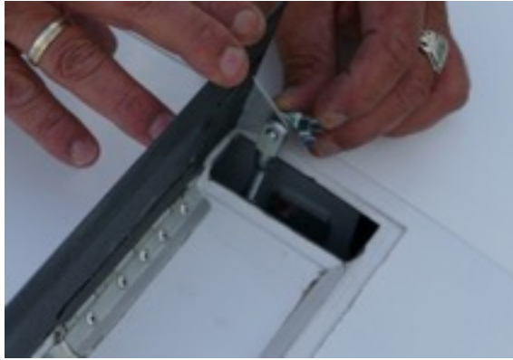
Störklappe anschließen und Sicherung aufstecken
